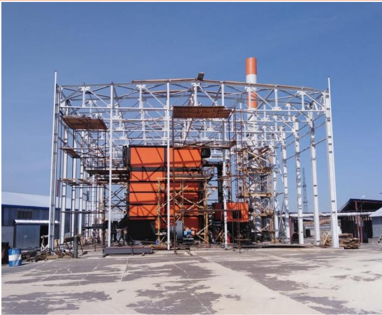
Здание котельной из сборных элементов
