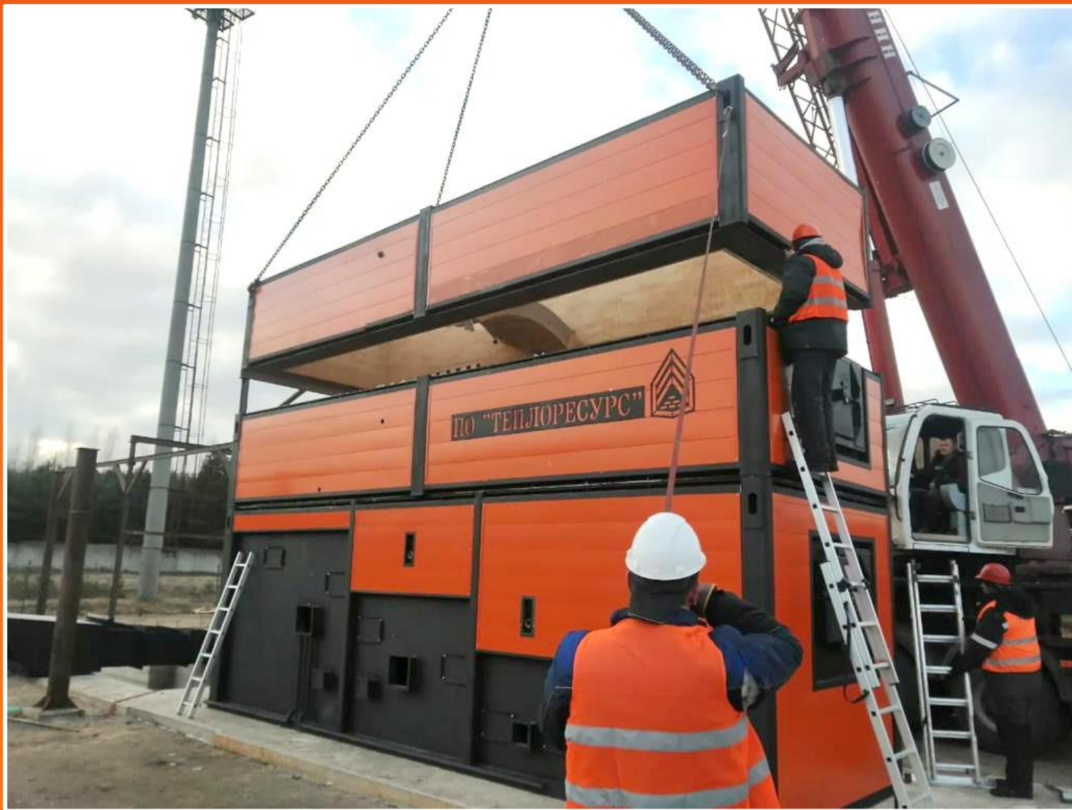
Монтаж теплогенератора
