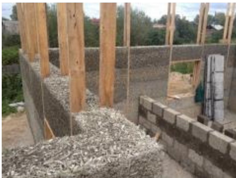
Рисунок 2 — Арболит построчного изготовления в сочетании с легким каркасом из досок.
