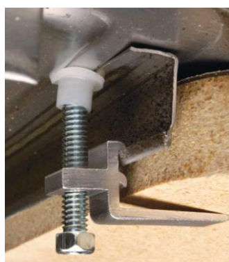
Рис. 8.24. Вариант соединения кухонной мойки со столешницей
