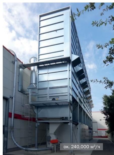
Фильтр MultiStar с каналом обратного воздуха с элементом
