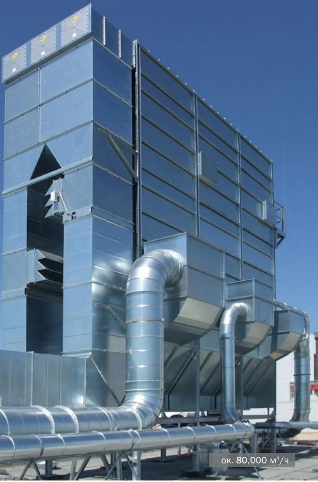
Фильтр MultiStar со шнеком и регенерацией продувочными тележками • производство спортивного оборудования
