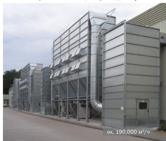
Фильтр MultiStar с каналом обратного воздуха с элементом приточной
