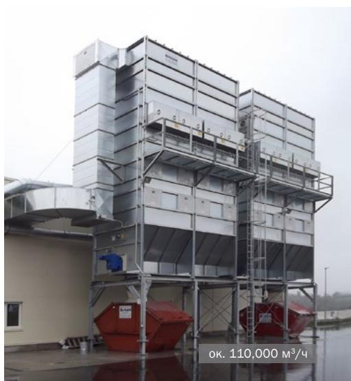
Фильтр MultiStar со шнеком, с импульсной регенерацией • внутренняя отделка
