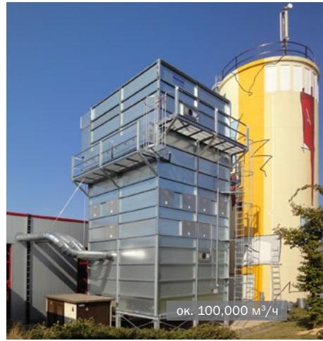
Фильтр MultiStar с ворошителем с импульсной регенерацией
