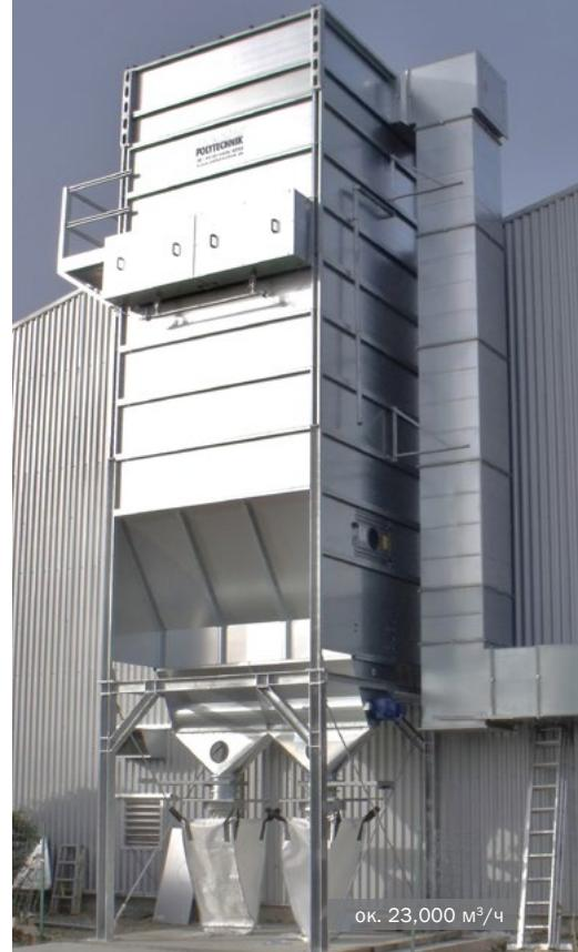
Фильтр MultiStar с импульсной регенерацией в производстве пластика
