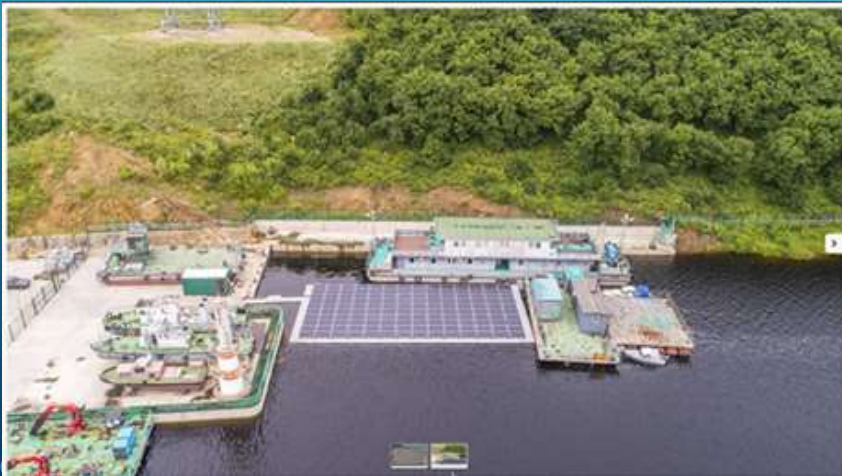
Наплавная СЭС на НБГЭС
