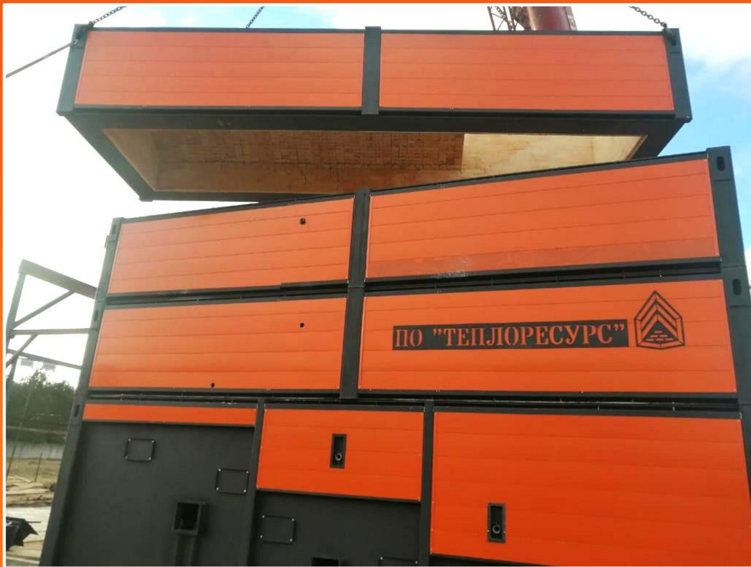
Монтаж теплогенератора
