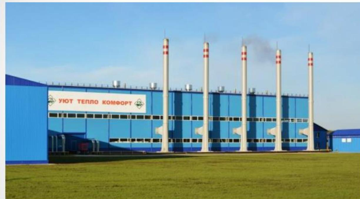
В сентябре 2016 года в п. Костылево запущена в работу первая производственная модульная котельная, работающая на пеллетах. Два котла по 100 кВт мощности каждый полностью автоматизированы и работают дистанционно - оператор управляет с помощью мобильной связи.
