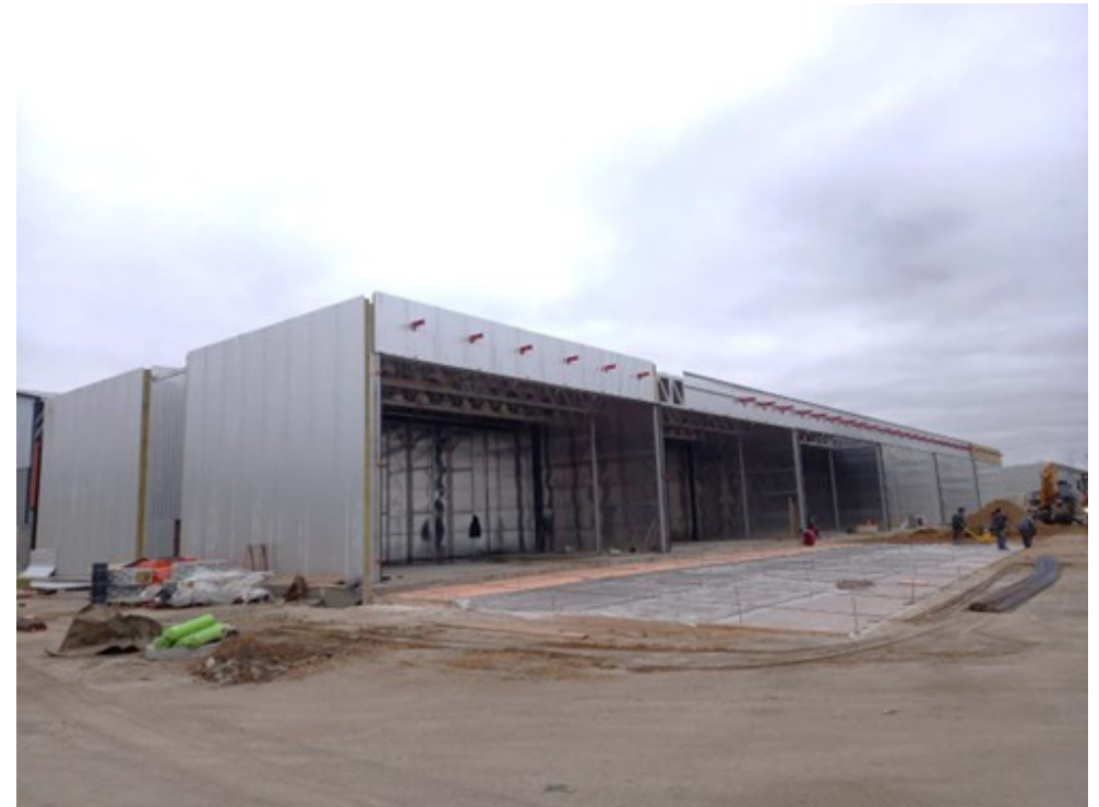
Рисунок 2. Комплекс из 20 камер Remdrev объемом по 200 м 3 каждая в процессе строительства
