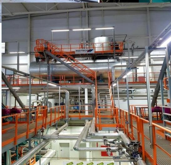
Состав установки: два паровых котла по 12 МВт и турбоагрегат на 3 МВт.
